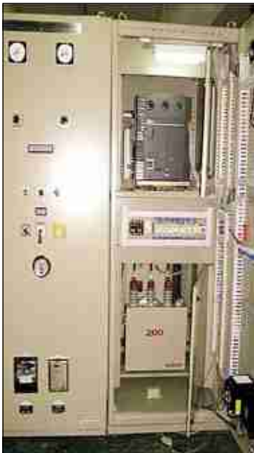
《3.3kV 3P 50Hz 300kvar》
