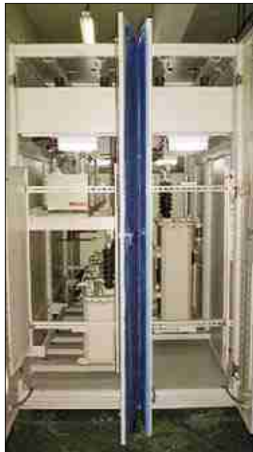
《10kV 3P 50Hz 700kvar》
