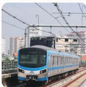
Dự án Metro Bến Thành - Suối Tiên
