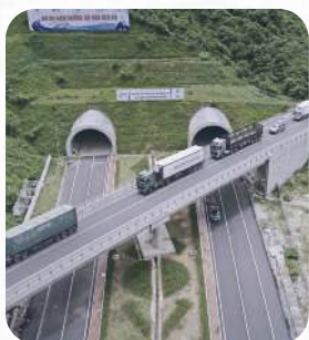
Dự án Hầm Đèo Cả
